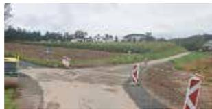
Zurzeit werden in Launsdorf am Buchberg neue Wasserleitungen, Breitband- und Wasseranschlüsse installiert. Den Abschluss bilden die Schotterung und die Asphaltierung.
